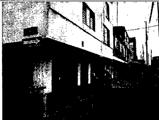
Foto 1. Vista general del predio.
